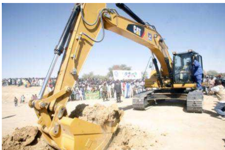
Figure 4 : Lancement des travaux d'aménagement du périmètre de Alatona – janvier 2010 (source : site internet du MCA Mali).
